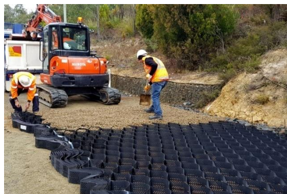
Fig. 2 : Geo web pavement construction
