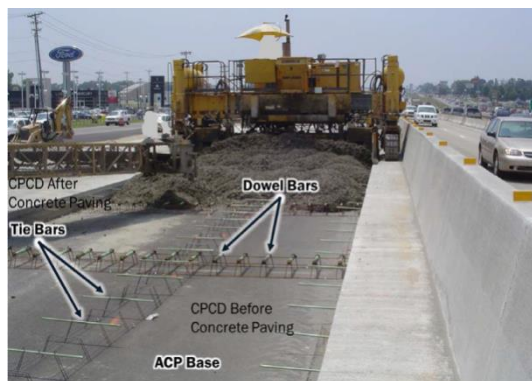
Fig. 1 : CPCD road construction
